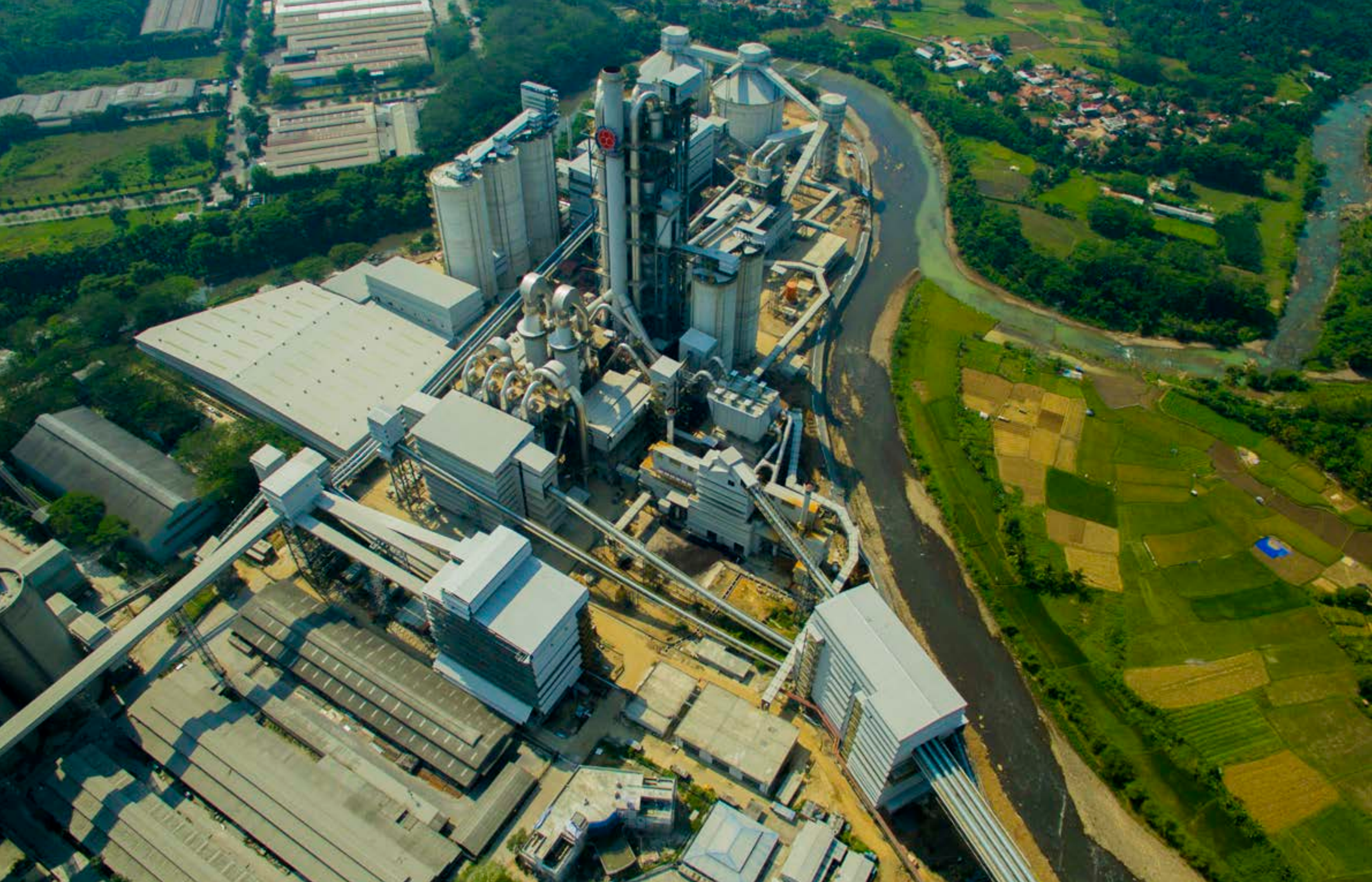
Peresmian pabrik baru Plant 14 di Kompleks Pabrik Citeureup di Bogor, Jawa Barat, dengan kapasitas terpasang 4,4 juta ton semen per tahun.
