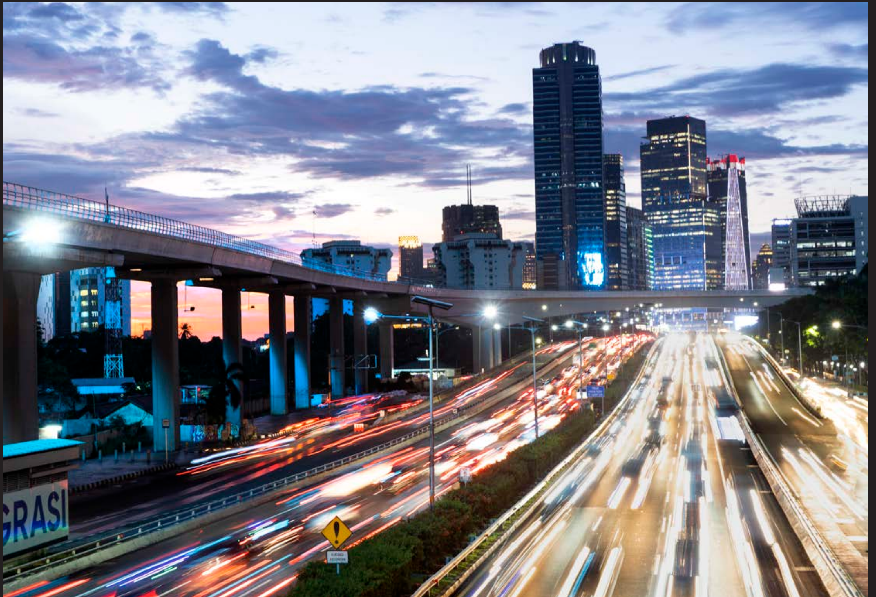
Jembatan Rel Lengkung ( longspan ) LRT Kuningan
