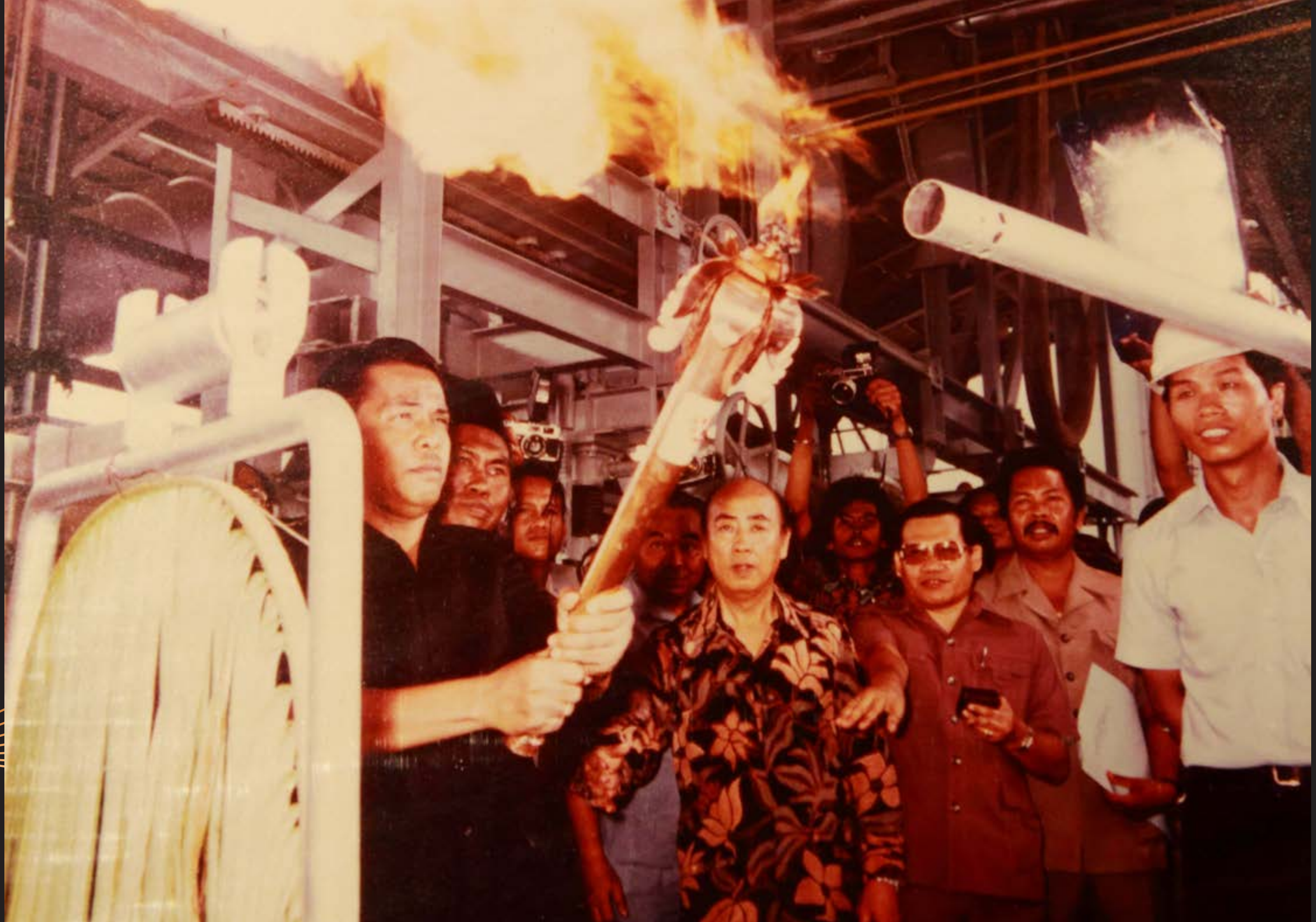
Kiln Firing Plant 3 tahun 1978.
