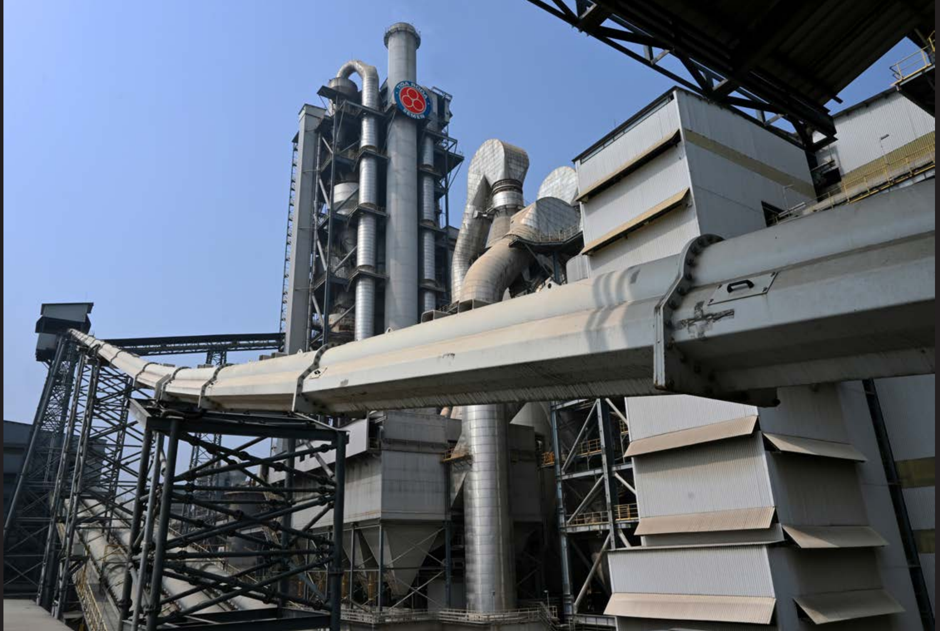
Plant 14 Kompleks Pabrik Citeureup merupakan salah satu fasilitas milik Indocement yang telah memanfaatkan bahan bakar alternatif. RDF yang diproduksi oleh TPST Bantargebang digunakan sebagai sumber energi oleh pabrik ini.
