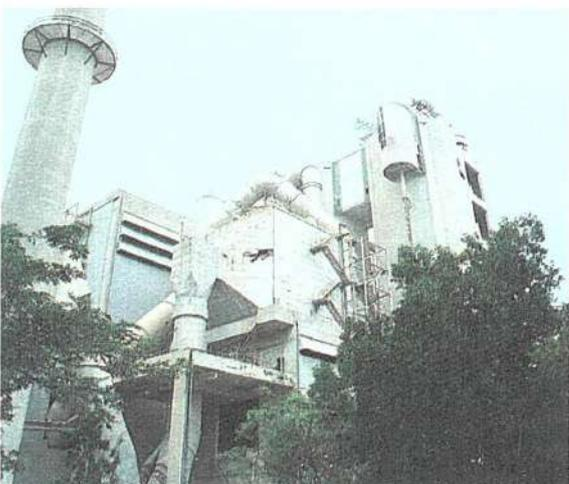
Pemasangan lima alat penangkap debu "Electrostatic Precipitators" di pabrik semen, Citeureup, menjamin bahwa tingkat emisi debu tetap jauh di bawah ambang batas toleransi yang ditetapkan Pemerintah.
